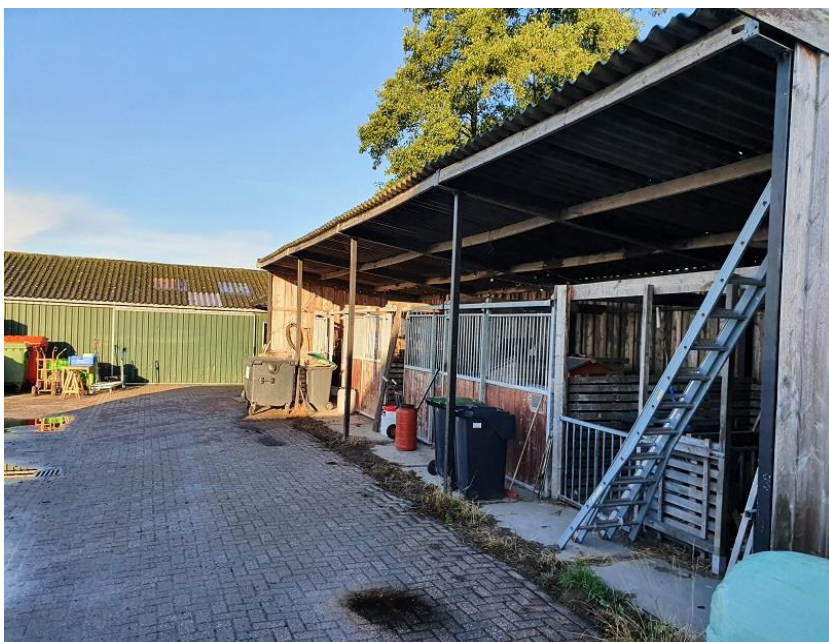
Figuur 4. Huidige situatie schuur met op de voorgrond de overkapping (bron: Dantuma Advies).
